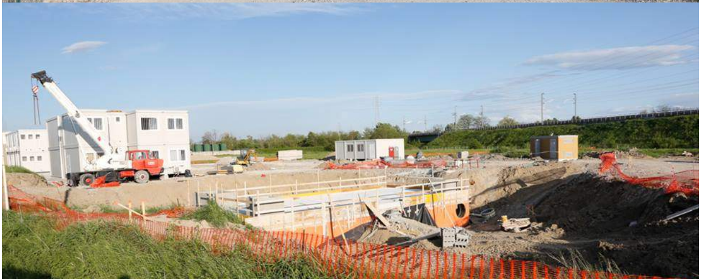
sopra: foto del cantiere delle opere complementari Ti-Bre a Bianconese (aprile, 2016). Giusto di fronte a questo cantiere c'è l'oasi naturale protetta Golena Taro.
