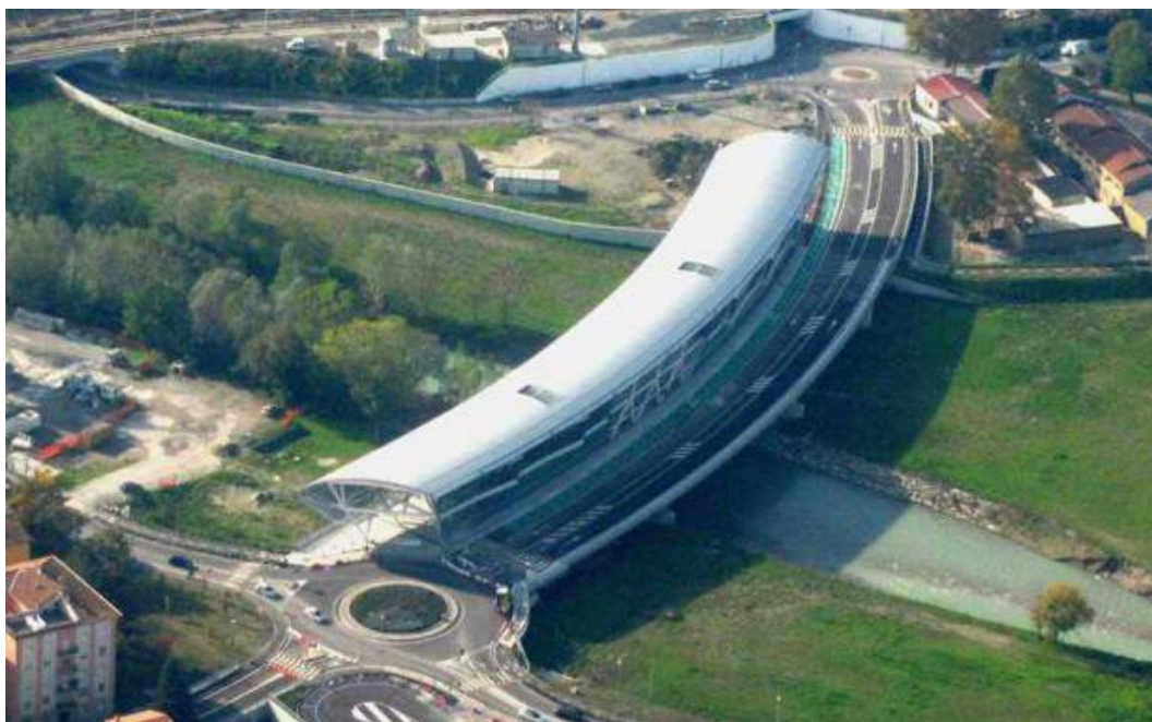
Fig. 8. Il famigerato Ponte Nord: a 4 anni dall'inaugurazione è ancora abbandonato. Pizzarotti S.p.A. ha guadagnato quasi 25 milioni di euro (di denaro pubblico) per costruire quest'opera.
