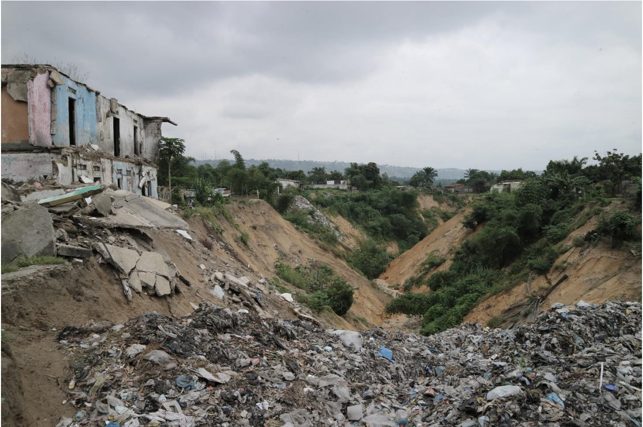
A fianco della discarica informale, abitazioni crollate a causa dell'avanzamento della gola erosiva Ngafani, comune di Selembao, 2018.
